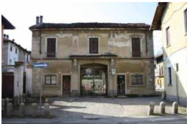
Villa Medolago – Edificio di ingresso da via Dante
