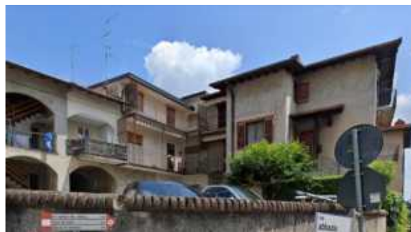
Pur mantenendo il sedime originario, le strutture di copertura dell'edificio risultano modificate e incoerenti con la matrice del Nucleo di Antica Formazione.
