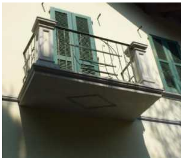
Balcone a ringhiera. Struttura lignea originaria ma utilizzo di ringhiera non conforme ai tipi tradizionali.
