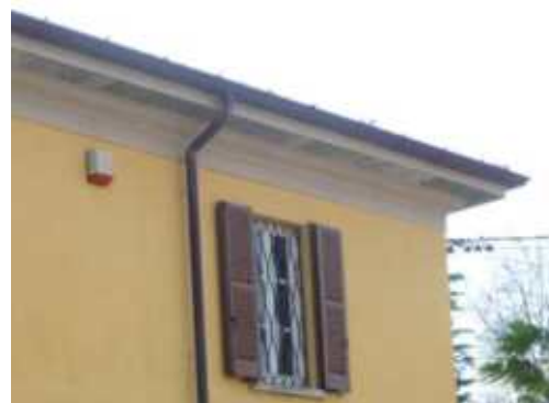
Gronda in pietra con cornicione riferibile a modelli architettonici riconoscibili
