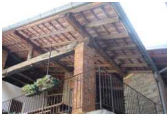
Sottogronda (e struttura) lignea senza assito
