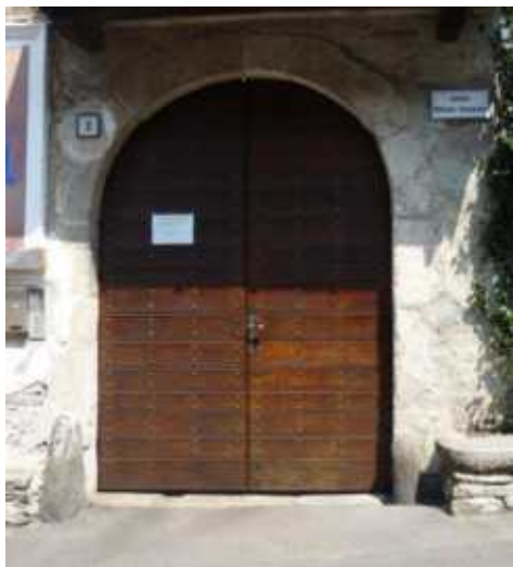
Portoni con riquadratura del vano in elementi lapidei
