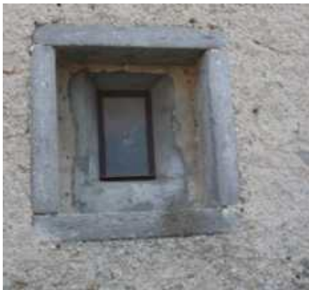
Esempio di elemento lapideo originario da mantenere
