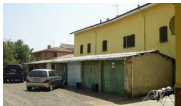
Edifici accessori recenti.
