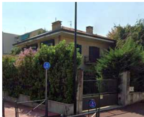
Esempio di edificio di recente isolato ed estraneo alla cortina edilizia e alla tipologia originaria
