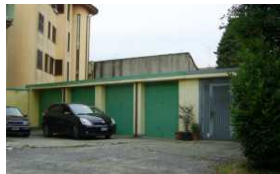
Edifici accessori recenti.
