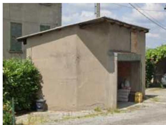
Edifici accessori recenti.
