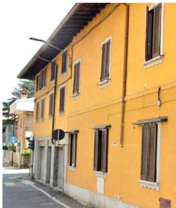
L'edificio mantiene sedime e sagoma originari, ma è connotato da alterazione linguistica degli elementi di chiusura (vetrine, serrande commerciali, mantovane, ecc..)
