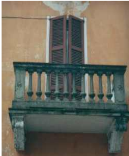
Esempi di balconi isolati con struttura in calcestruzzo o pietra e parapetti di diversa fattura (lapideo o ringhiera).
