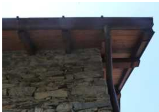
Sottogronda con struttura lignea e assito. Lattonerie in rame.
