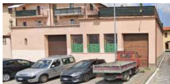
Edifici accessori recenti.
