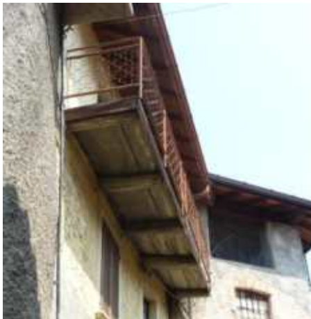
Balcone a ringhiera. Struttura lignea originaria ma utilizzo di ringhiera non conforme ai tipi tradizionali.
