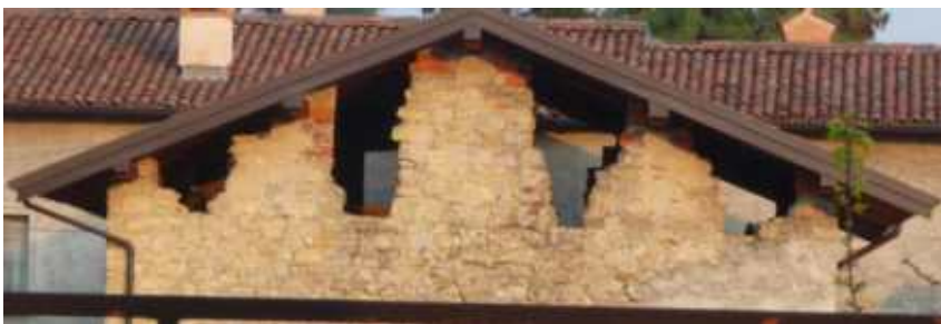
Negli edifici rustici, laddove presente, l'intonaco è spesso realizzato con la tecnica del "rasapietra"
