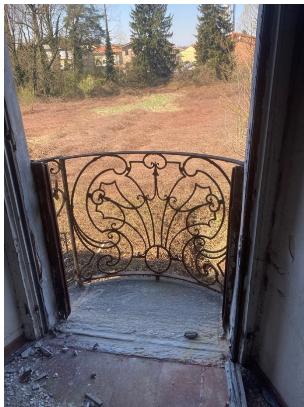
I parapetti in ferro battuto dei balconi
