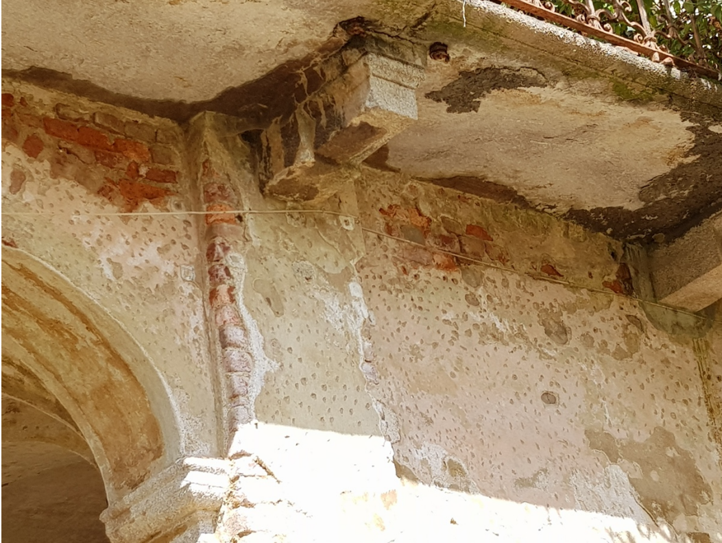
Dettaglio degli intonaci della facciata verso corte al di sotto della balconata: si evidenzia la originaria tinta rosa delle campiture d'intonaco con le sottolineature color sabbia delle cornici degli archi
